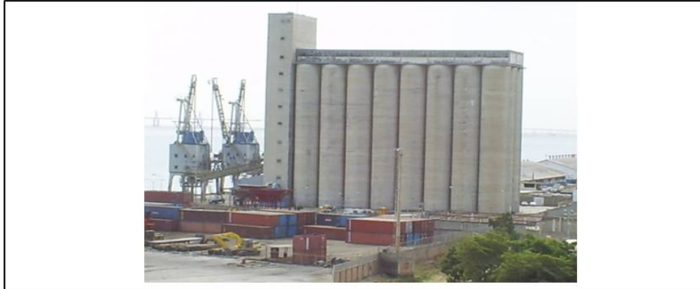
Figura 4. Silos Verticales de Concreto
